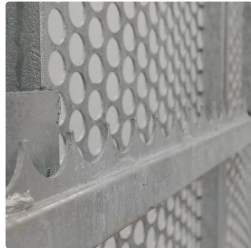
Zusätzlicher Punktkamm Für die Trennung der Fans
