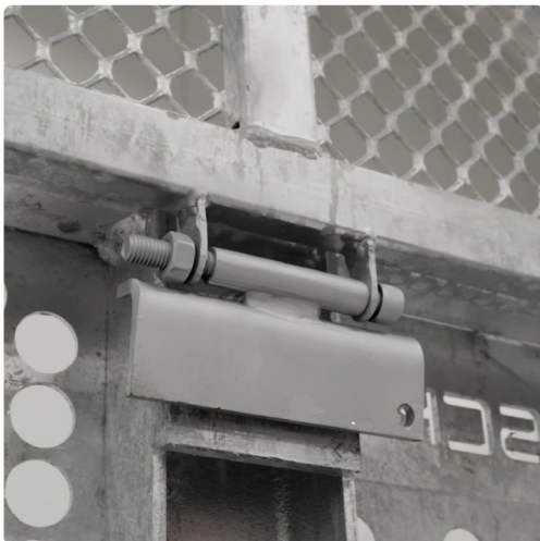
Sicherungsstift für 3 Höhenpositionen
